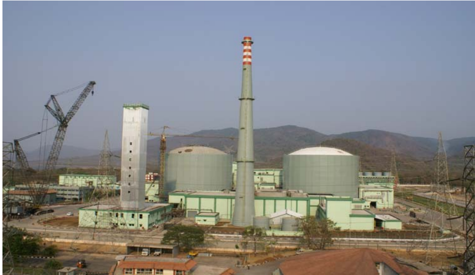
図表19：カイガ原子力発電所3号機の完成写真（II-7）
