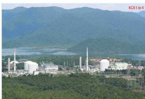
カイガ原子力発電所
