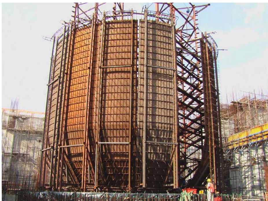
図表 17：カルパッカムでの高速増殖原型炉 (PFBR) 建設現場 (II-7)
