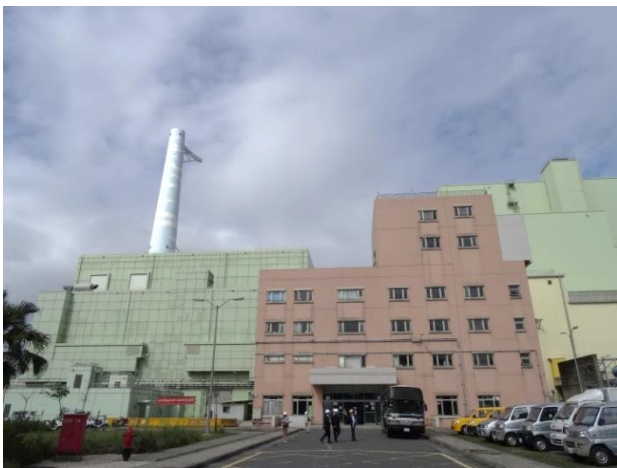
1号機原子炉建屋外観
