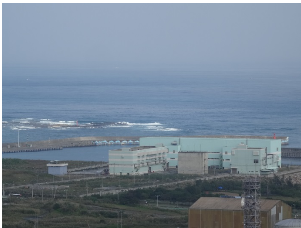
循環水ポンプ建屋
