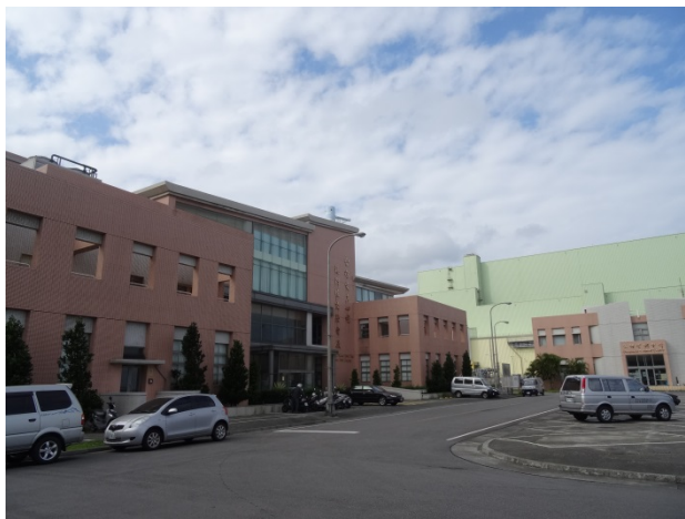
龍門発電所事務局ビル外観
