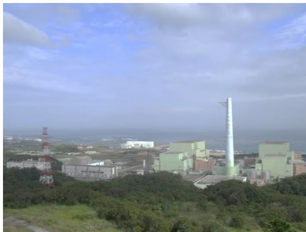
龍門発電所外観
