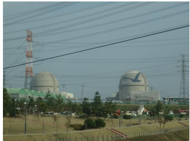
新古里 3、4号機外観
