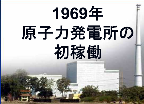
タラプール (TAPS) 1・2号機
