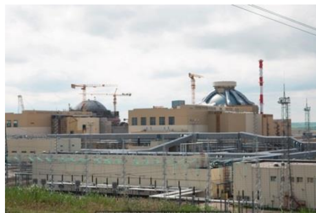
建設中のノボボロネジⅡ-1,2号機
