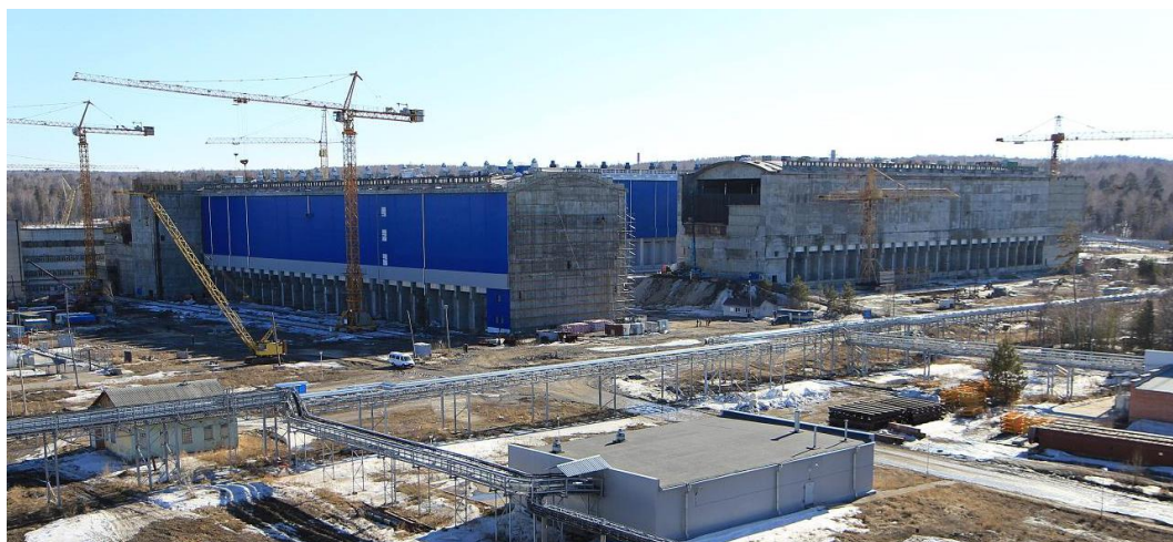
建設中のVVER-1000用使用済み燃料貯蔵施設 (乾式、8000tHM、2015年操業開始)
