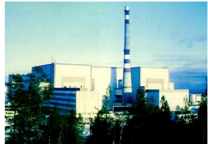
コラ原子力発電所(VVER-440×4基)
