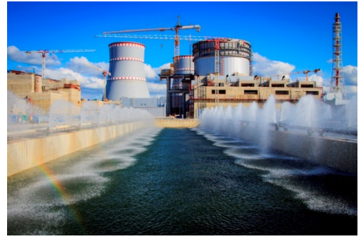
レニングラード原発第2 (建設中)
