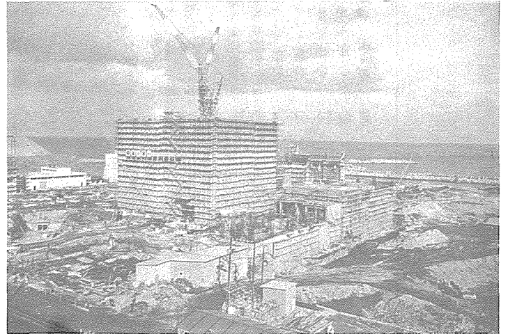
写真2 建設進む福島1号機 (右手は2号機基礎掘削現場)
