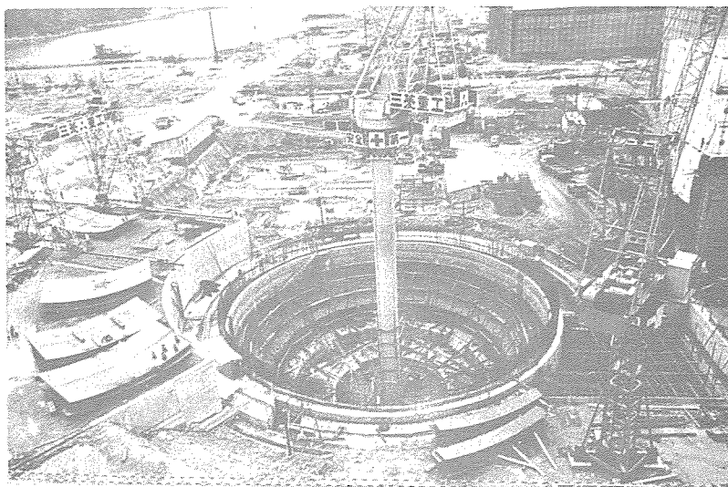
写真4. 2号機格納容器組立工事
