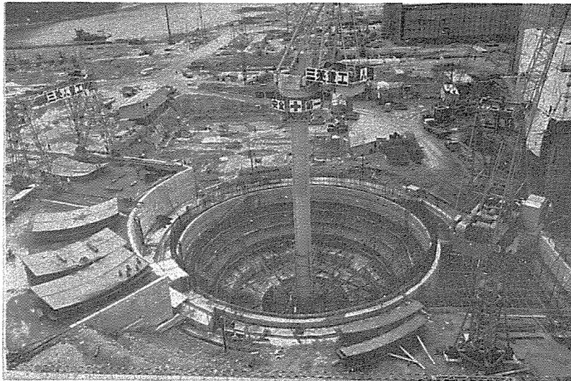
写真 4. 2号機格納容器組立工事
