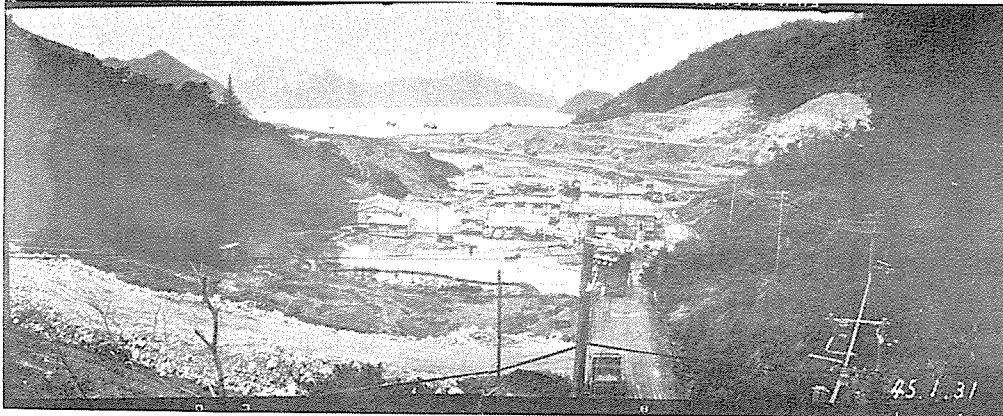
写真2 高浜原子力発電所仮設用地全景
