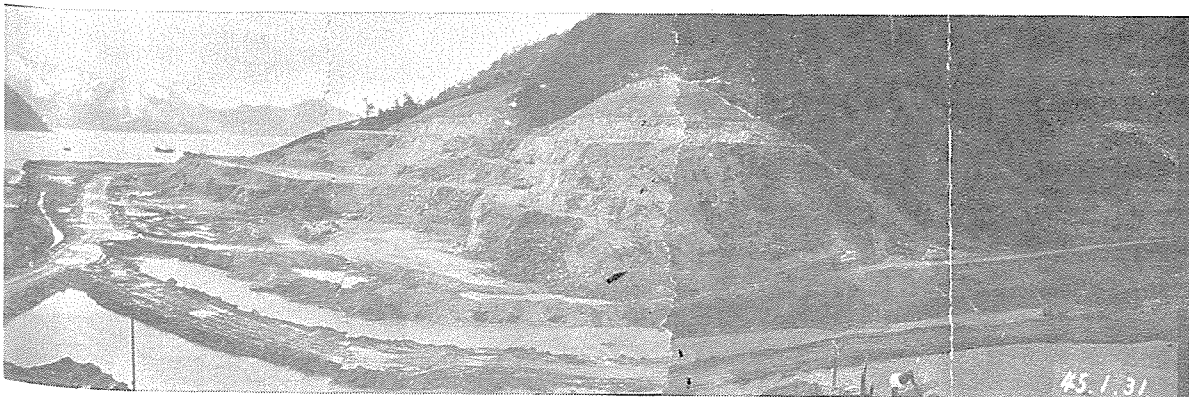
写真3 高浜原子力発電所1号炉附近工事状況
