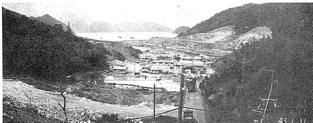
写真2. 高浜原子力発電所仮設用地全景
