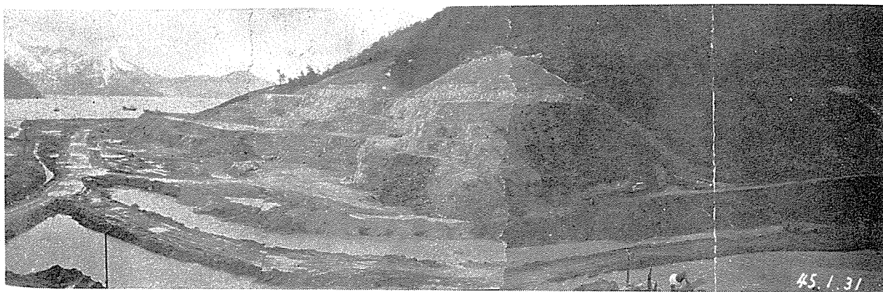
写真3. 高浜原子力発電所1号炉付近工事状況
