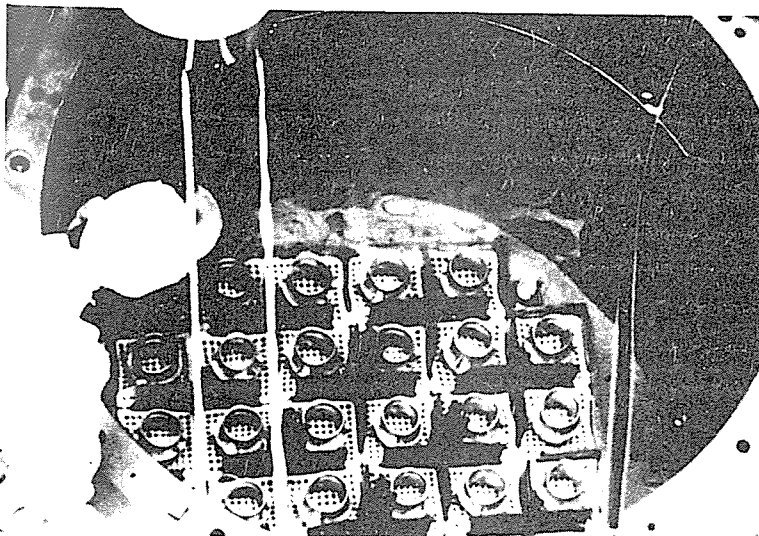
3 2 体の燃料装荷を終って2 次中性子源を左の方に入れて いるところ（燃料集合体の間 に、黒く見えるのが制御棒， 右肩の所に光って見えるのが 1 次中性子源棒の頭）
