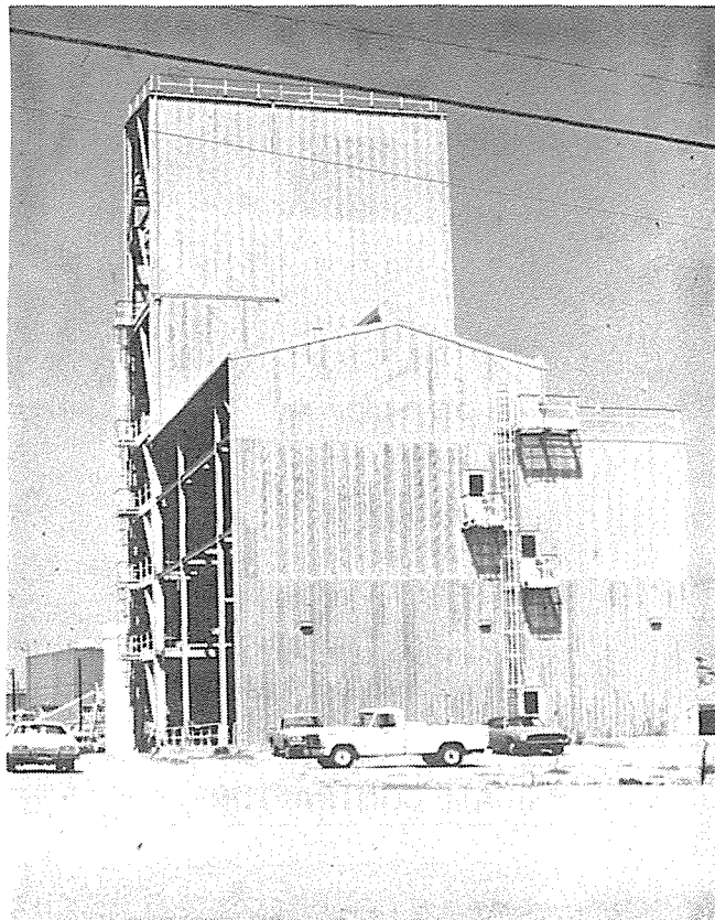
LMEC ナトリウム・ポンプ試験施設
