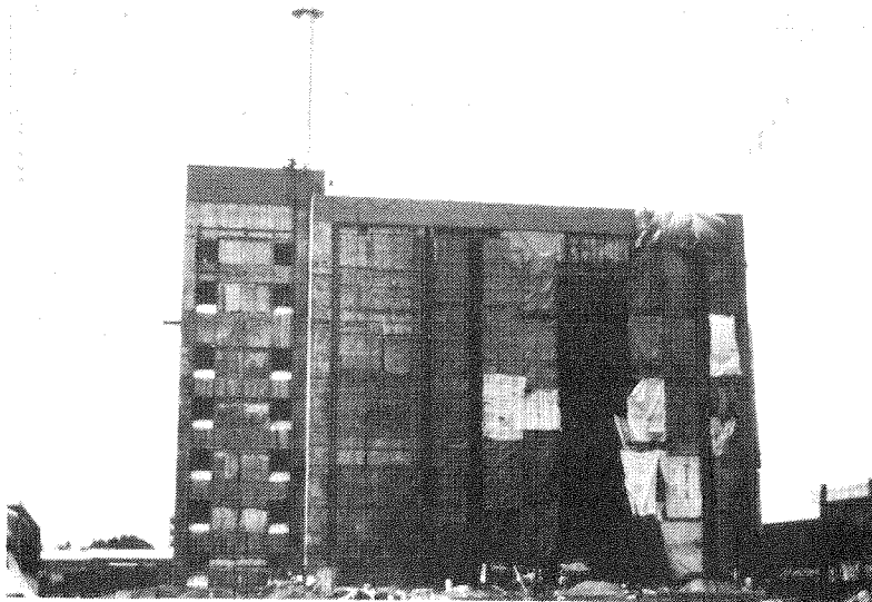
部分的に完成したMPR-30の原子炉建屋
