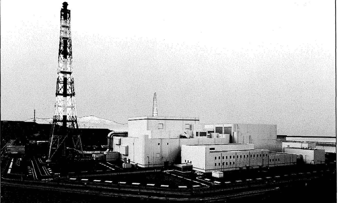
東京電力㈱殿、柏崎刈羽原子力発電所・第5号機
