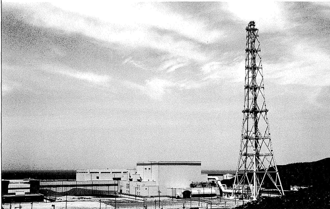
東京電力㈱、柏崎刈羽原子力発電所・第4号機
