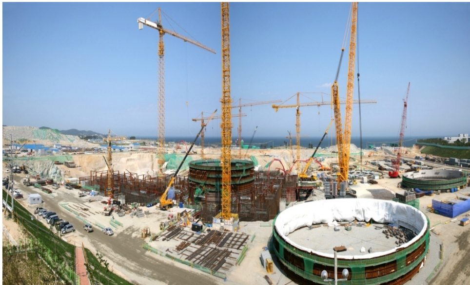
図表 16：新古里 3・4 での APR1400 の建設風景
