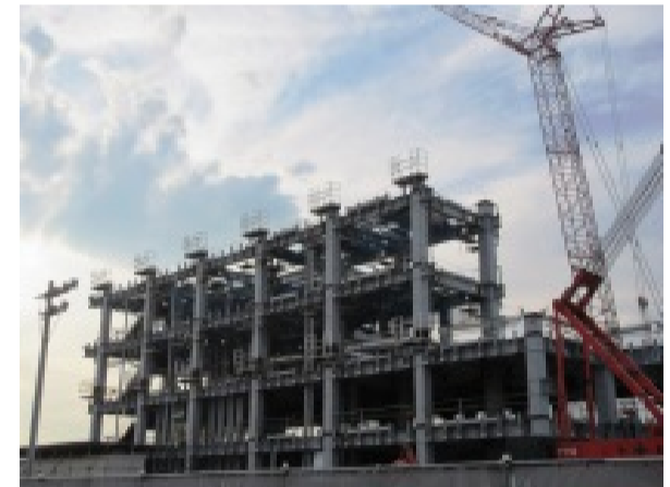
作業員約1,200名が利用できる 構内大型休憩所(地上9階建) 2014年度末完成を目指して建設中
