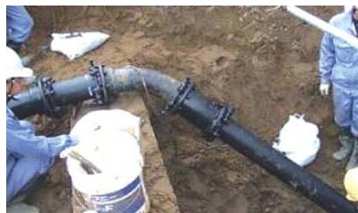
消火系配管破損後の復旧状況
