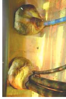
貫通部処理（床下）
