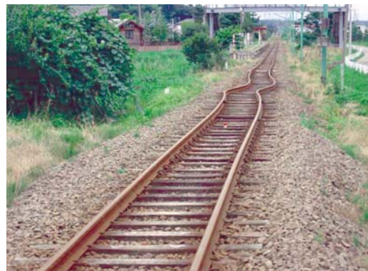
写真 2：地震の影響で曲がりくねった線路
