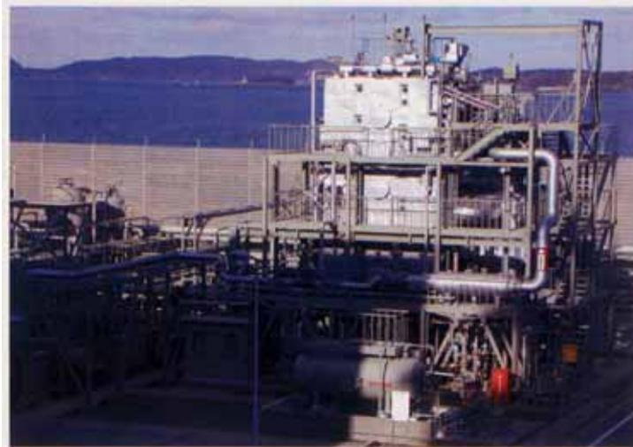
図 3.3 原子炉からの熱を利用した海水の淡水化プラント（蒸発法（MED））
