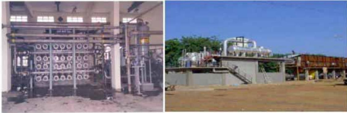
図 3.4 インドの Kalpakamm 原子炉に併設されているハイブリッドプラント
