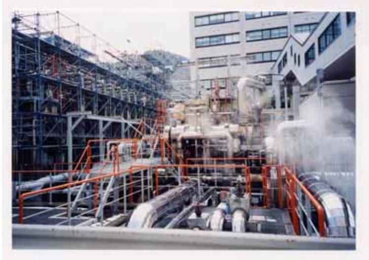
図 3.1 原子炉からの熱を利用した海水の淡水化プラント（蒸発法（MSF）
