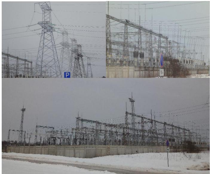
サイト内のスイッチヤード (開閉所)。イグナリナ原子力発電所は周辺諸国への電力供給用に建設されたため、送電インフラは豊富だ。300/330kV が 6 系統、110kV が 6 系統ある。
