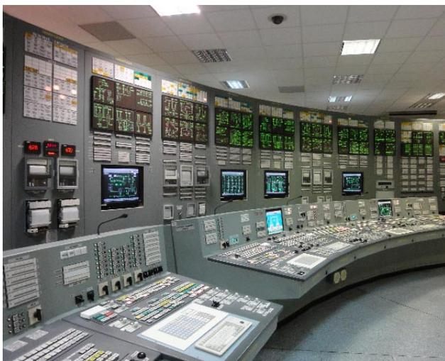
運転訓練センターには、150 万 kW 級 RBMK のフルスコープ・シミュレーターがある。
