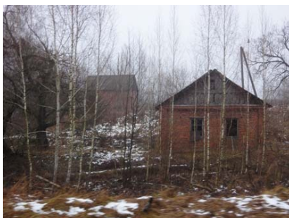
(放置された家々、順次埋設中)
