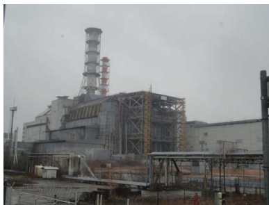
(4号炉石棺。右奥が新しい排気塔)
