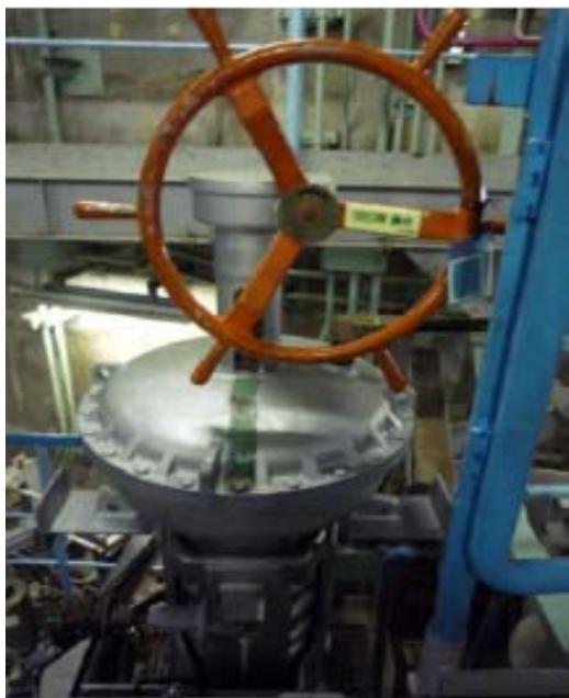
主蒸気逃がし弁の手動操作ハンドル
