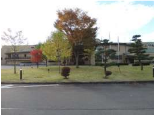
写真1 講習会場全景 青森原燃テクノロジーセンターの全景
