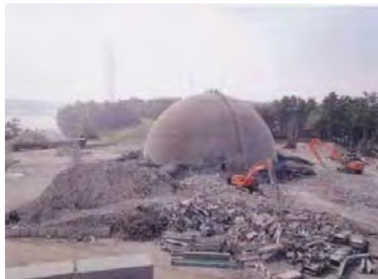
メインヤンキーの爆破解体
