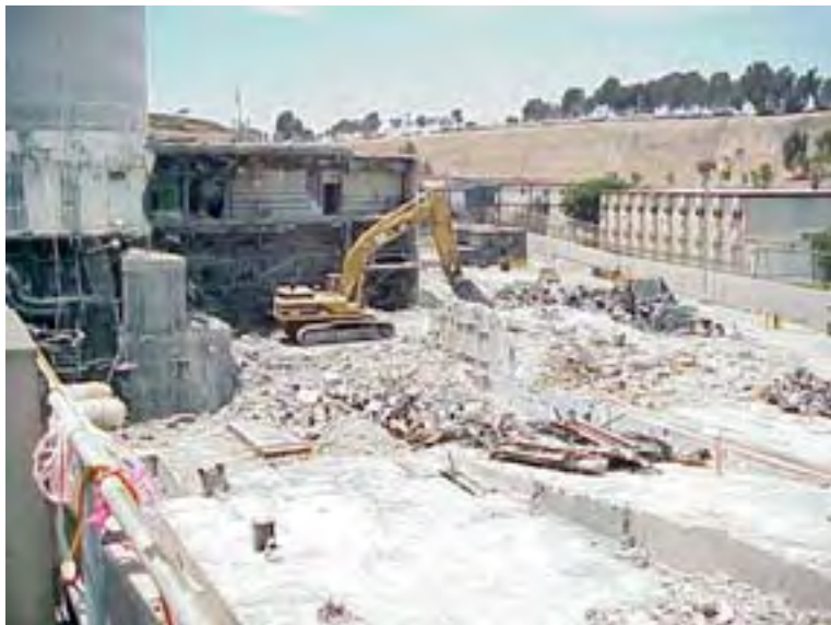
サンオノフレの管理建屋解体
