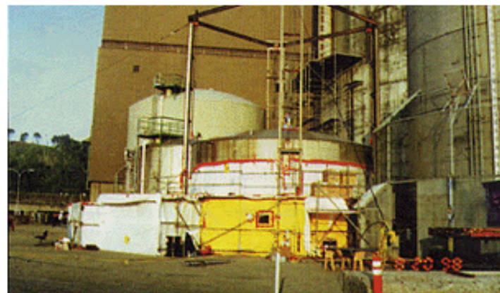
PWST約2/3解体終了時の状態 (外側の吊り下げ用の支柱及び作業用の密閉テントが見える)
