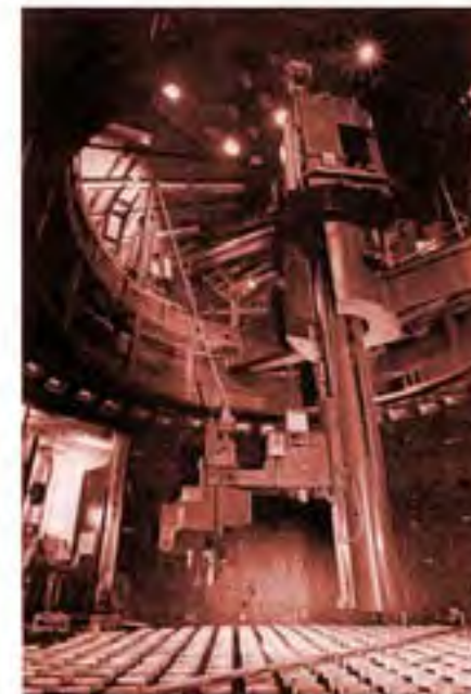
図4 放射化している炉内構造物の撤去に用いた 回転マニピュレータ型遠隔解体装置(KKN)
