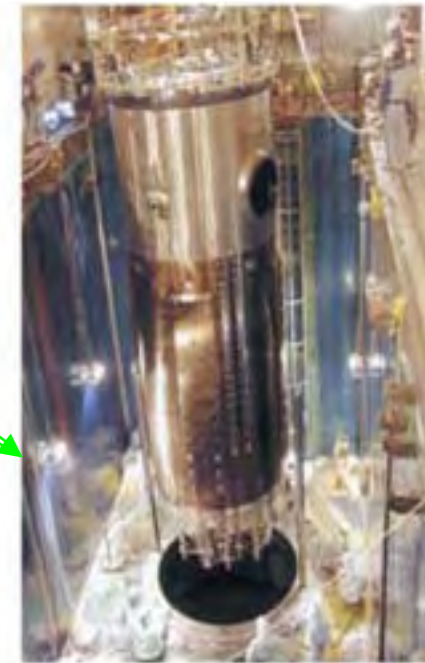
1号機原子炉容器炉内構造物取替工事
