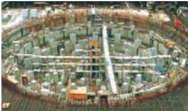
強固な岩盤上に設置
