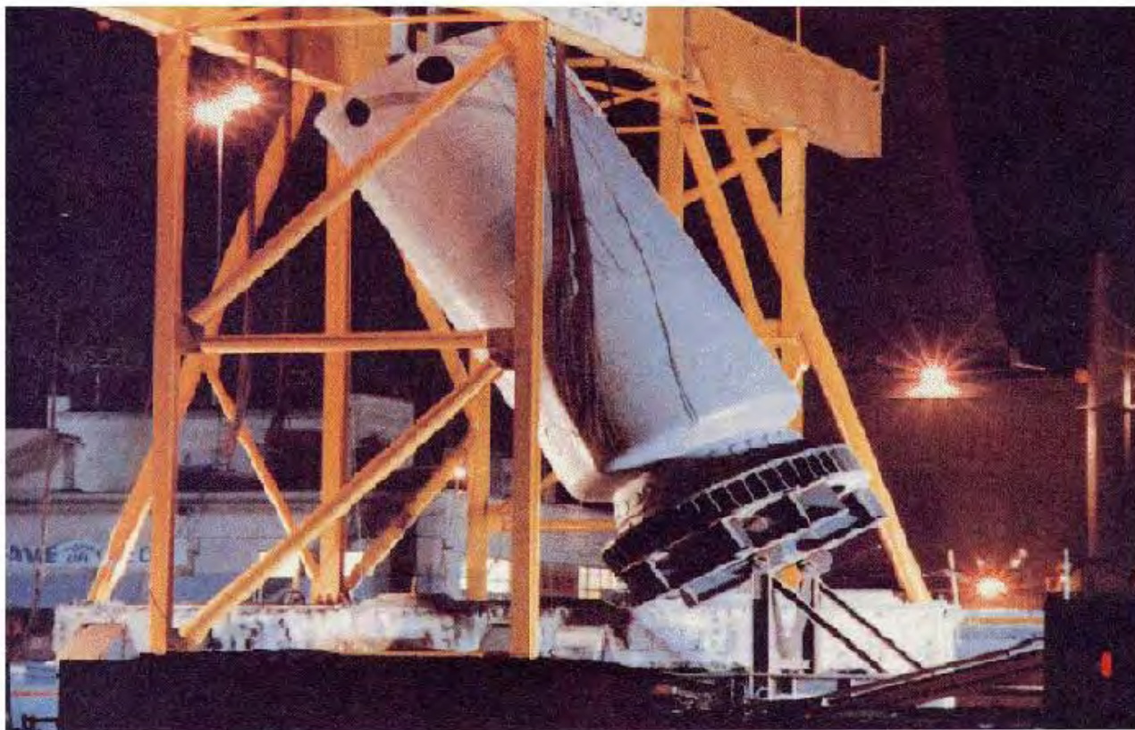
図3 搬出中の SHIPPINGポートの原子炉圧力容器
