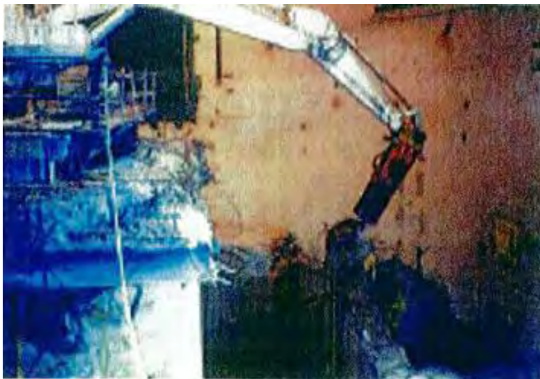
メインヤンキーの格納容器解体
