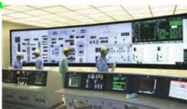
1,2号機中央制御盤等取替工事
