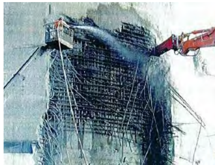
トロージャンの格納容器解体
