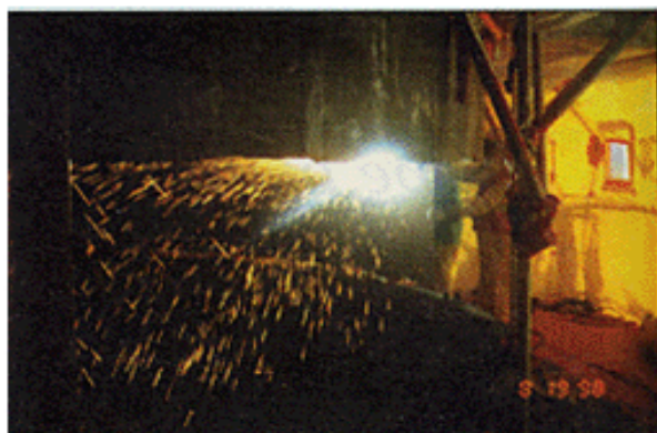
プラズマトーチによるタンク切断
