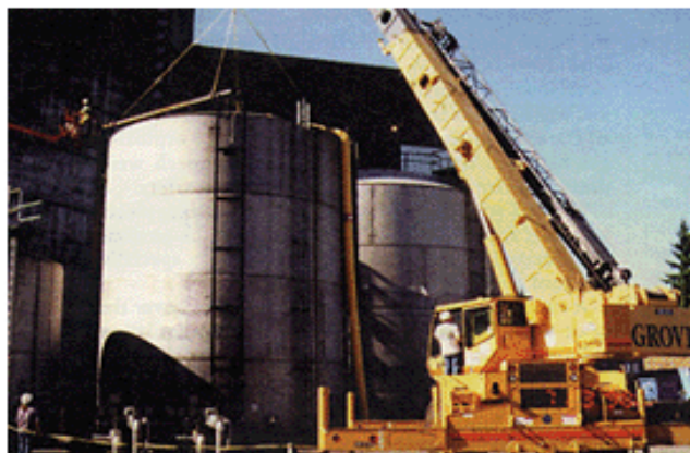
PWST解体作業準備(吊り下げ用の支柱設置)
