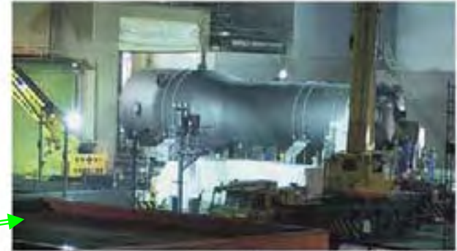
2号機蒸気発生器取替工事
