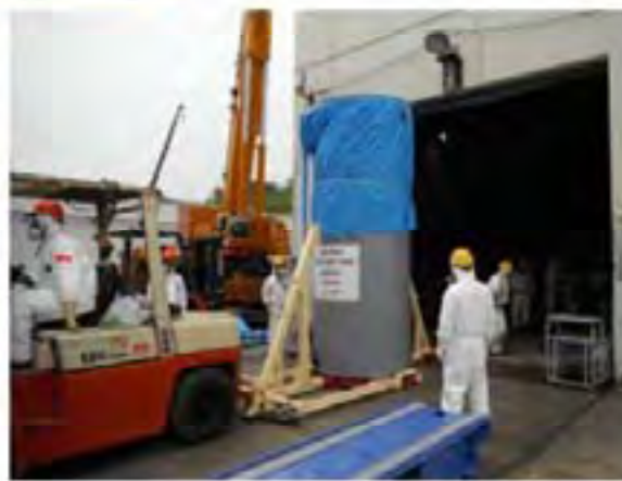
ベッセル搬入状況
