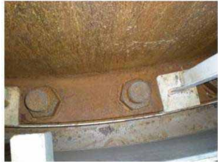
圧力容器基礎ボルトのトルク確認
