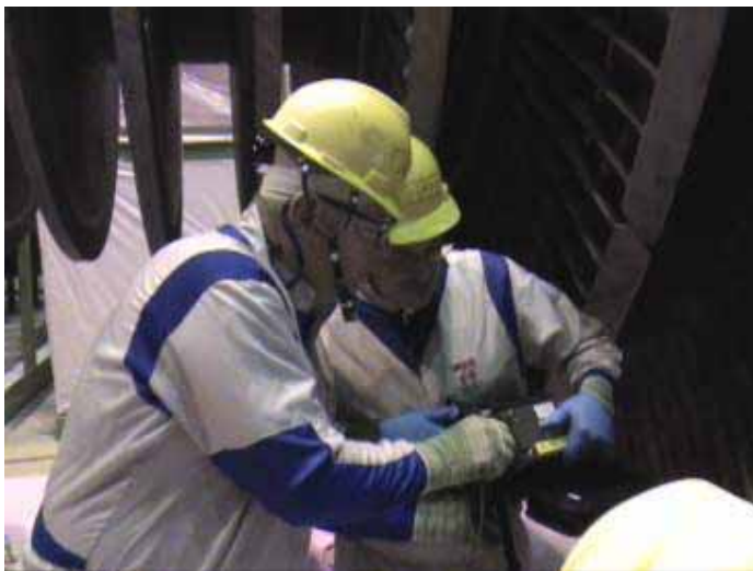
タービン超音波探傷検査
