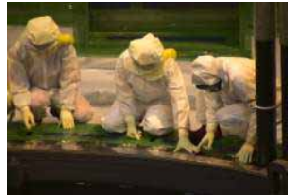
原子炉圧力容器と蓋の接合部の点検
