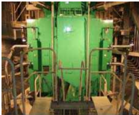
原子炉冷却材 再循環系ポンプ
