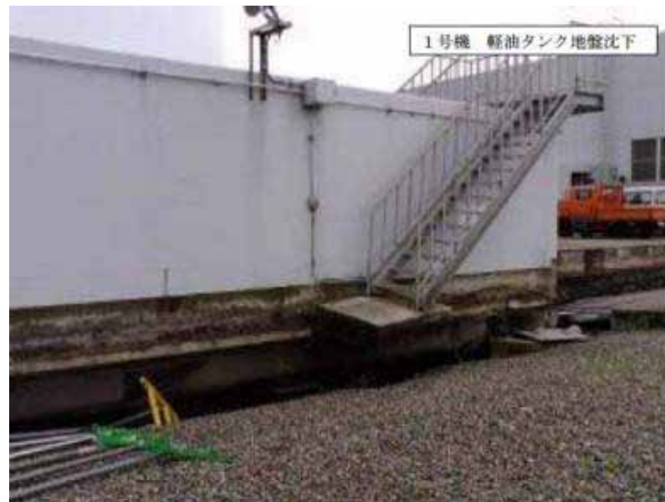
軽油タンク周辺地盤の沈下
