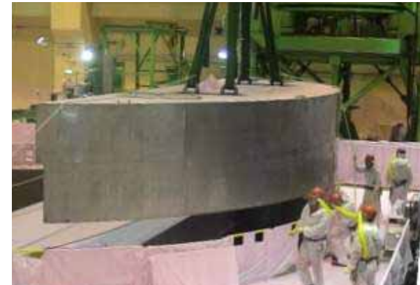
7号機原子炉開放作業
