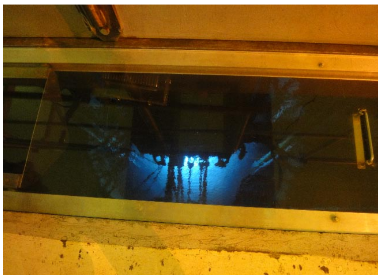
マリア炉の炉心。深さ 10m のプールの底にある
