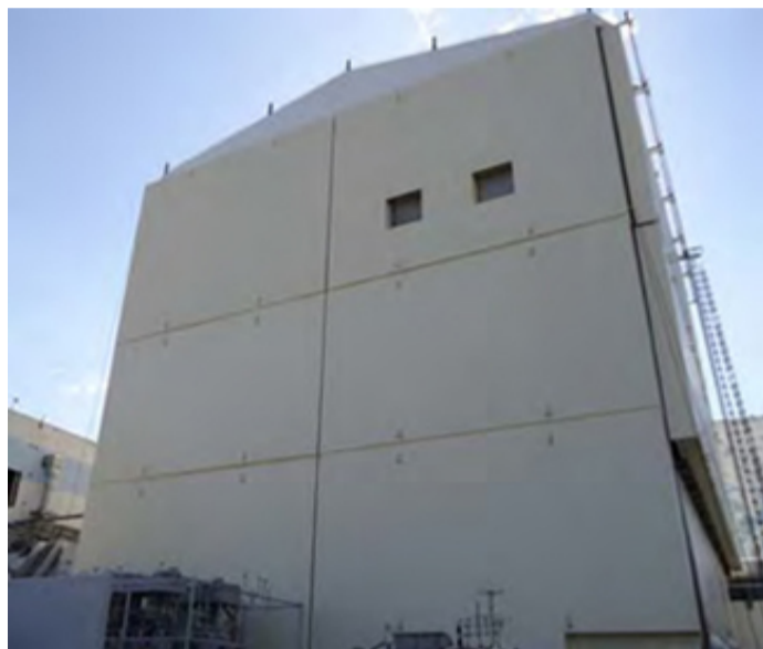
1号機原子炉建屋カバー
