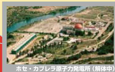
ホセ・カブレラ原子力発電所 (解体中)
