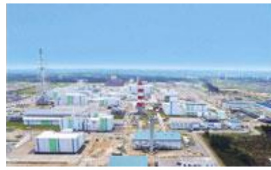
六ヶ所再処理工場
