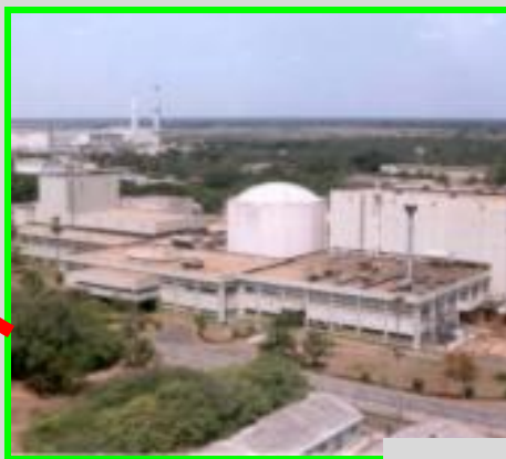
FBTR、40MWt、13.5MWe ループ型(Pu-U)炭化燃料 1985年より稼働
