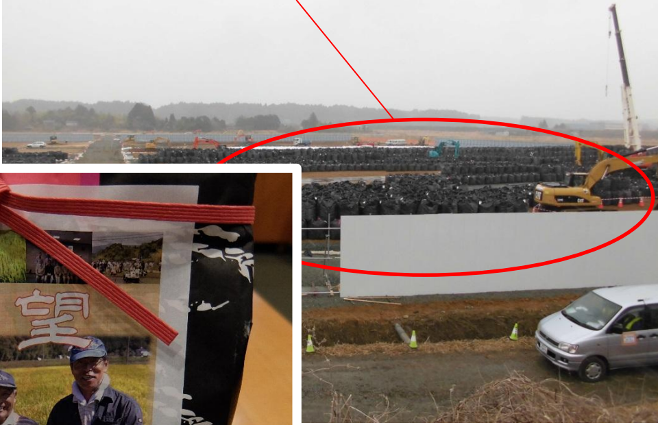
除染作業によって出た廃棄物
