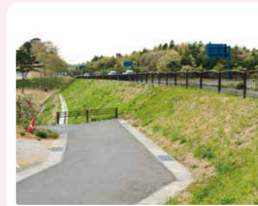
整備後の国道6号線 (写真提供: 広野町) Rebuilt National Route 6 (Photo credit: Hirono Town)
