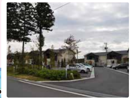
大熊町内に建設された東電寮 New TEPCO housing units in Okuma Town
