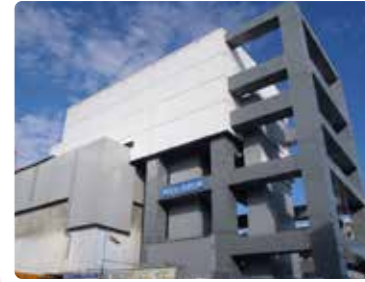
新たに燃料取扱装置を設置し 使用済燃料取り出しを完了 (4号機) (写真提供: 東京電力HD(株)) Completion of fuel removal from Unit 4 upon installation of new fuel handling equipment (Photo credit: TEPCO HD)
