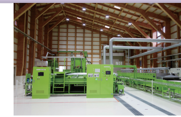
コドモエナジー:第一工場内設備
