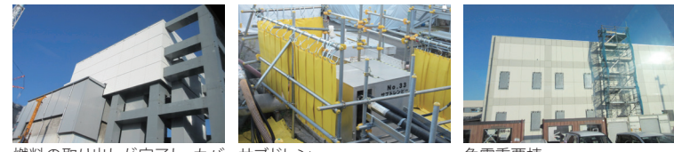
燃料の取り出しが完了し、カバーで覆われた4号機 サブドレン 免震重要棟
