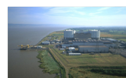
Oldbury Site (既設2基共に停止)
