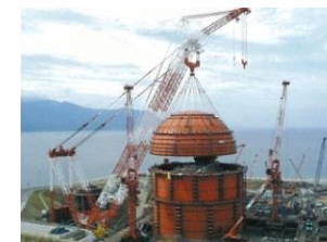
北海道電力(株)泊発電所3号建設風景
