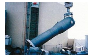
蒸気発生器取替工事
