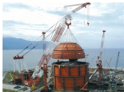
泊発電所3号機(建設風景)
