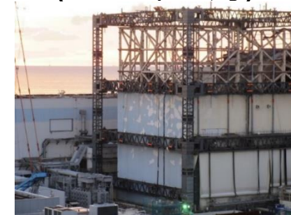
パネル撤去完了 (2016年11月)
