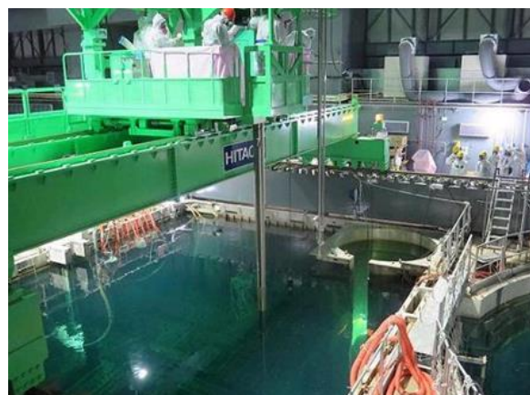
4号機燃料の取出し状況
