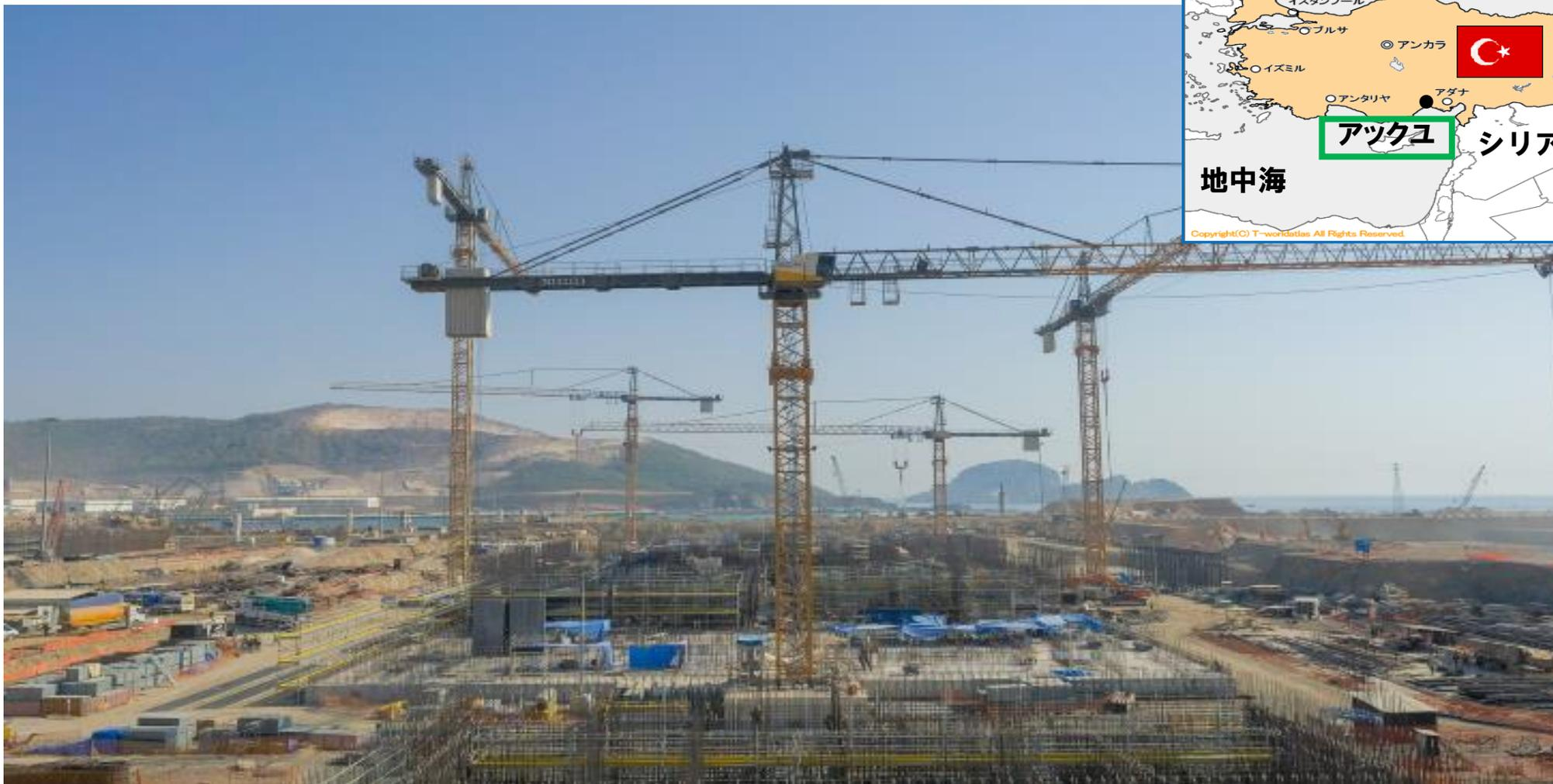
アックユ2号機 (VVER-1200) の着工 (4月8日)、6月にはベースマットが完成。ロシアが計4基を供給予定 ※なお同3号機も2021年3月10日、着工
