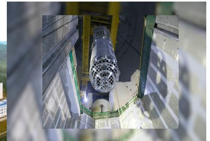
原子炉建屋内に据え付けられる炉内構造物 @カラチ2号機(2019年1月) (出典:CNNC)
