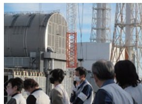
原子炉建屋を眺めながら号機ごとの使用済み燃料の取り出し状況を見る (提供:東京電力HD(株))
