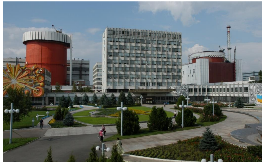
南ウクライナ原子力発電所（3基・300万kW）
