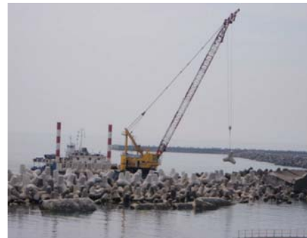
防波堤設置状況
