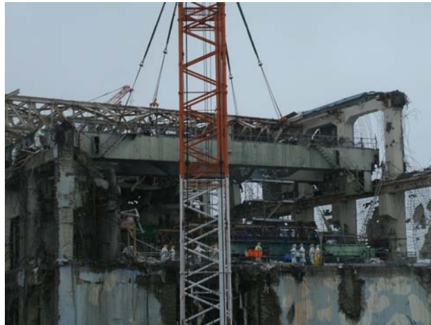
4号機原子炉建屋屋上の瓦礫の撤去作業
