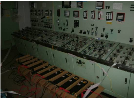
乗用車のバッテリーを必要な計器につなぎ込み
