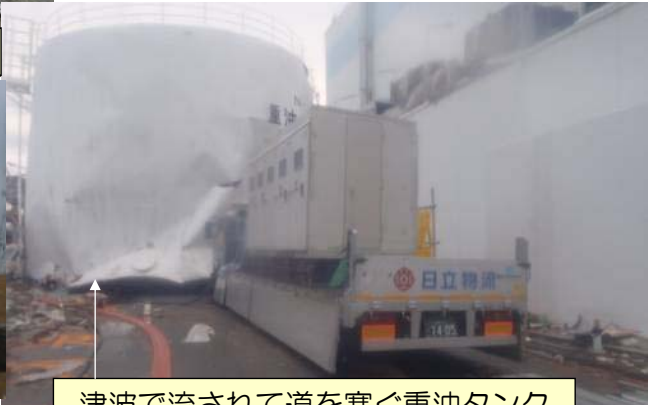
津波で流されて道を塞ぐ重油タンク
