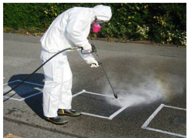
除染の様子(大熊町内) (撮影日:平成23年11月4日)
