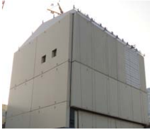
1号機原子炉建屋カバー設置
