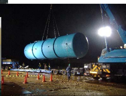
処理水受け用タンクのトレーラーへの積み替え
