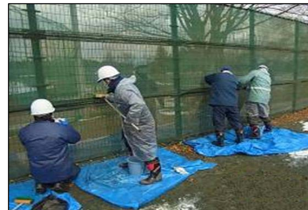
運動場ネットの除染作業
