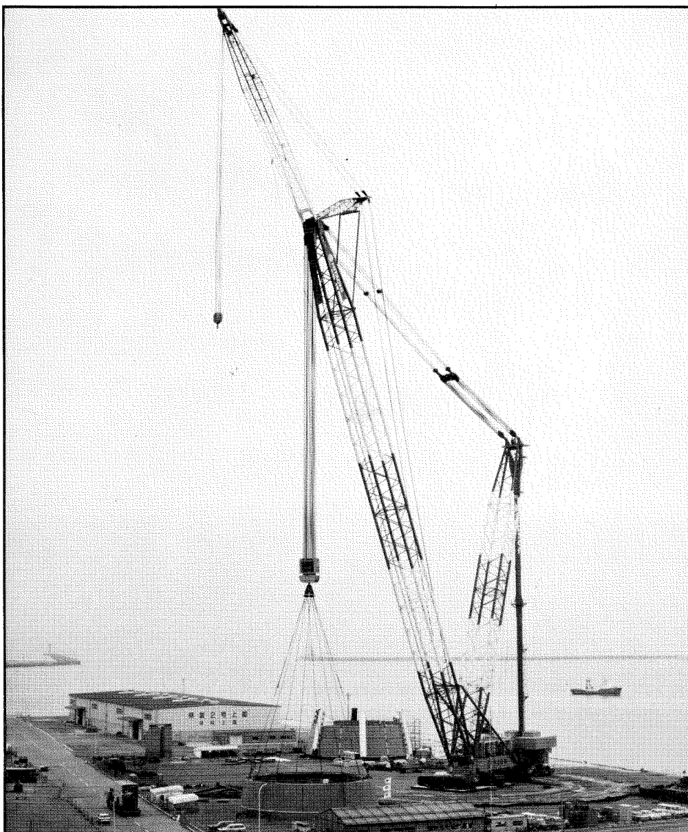
原子力発電所で活躍する超大型クローラークレーン
