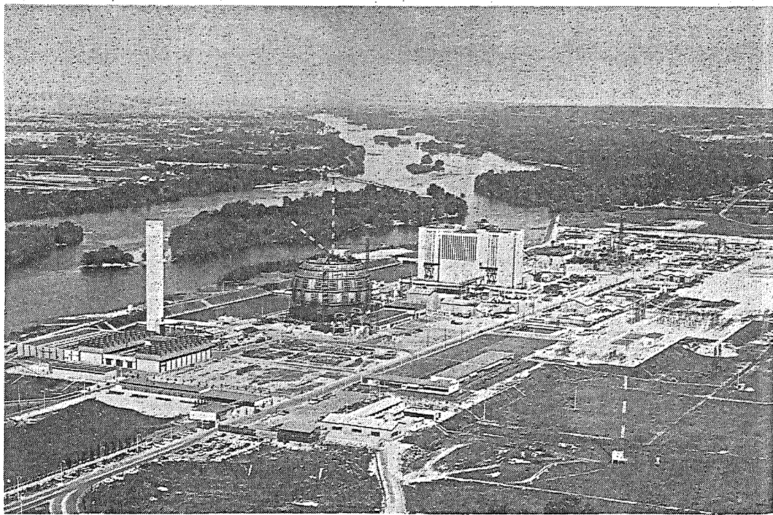
仏電力庁のシンノ原子力発電所＝球形容器は九月臨界に達したEDF1、その右の建物は建設中の同2。
