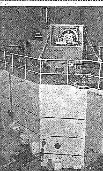
原研 JRR-1 とそのパイルオシレーター
