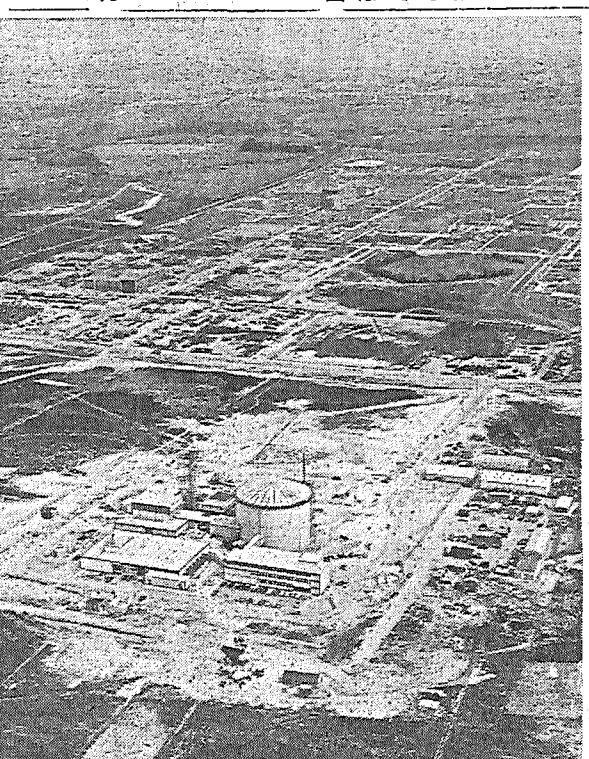
ウインフリスに建設中のHTGCR炉の全景
