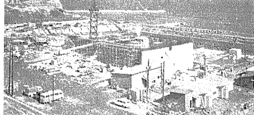
福島発電所建設現場
