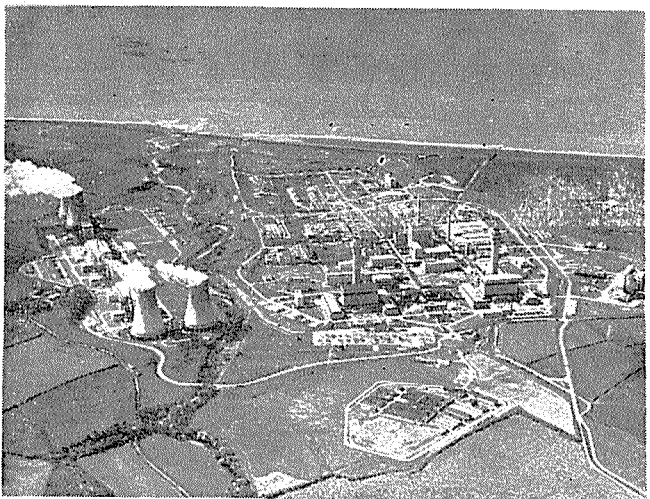
写真は英国最初の原子力発電所「ダウナ」が運転中のカンバーランド沿岸のサイト。ここにはAECのウインズケール再処理工場、Hero研究炉がある。
