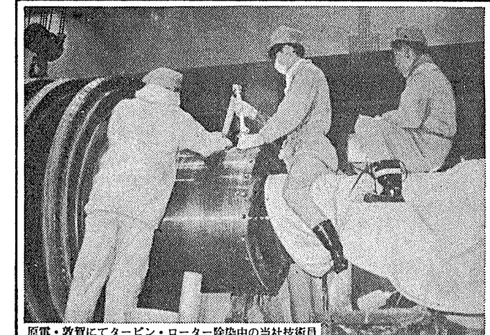
原電・敦賀にてタービン・ローター除染中の当社技術員
