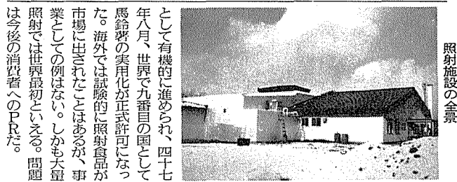
照射施設の全景
